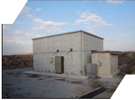
Kapalı Alan Patlayıcı Karakterizasyon Test Odası
